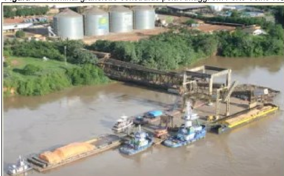
Figura 7 - Terminal graneleiro construído pela Amaggi em Porto Velho-RO
